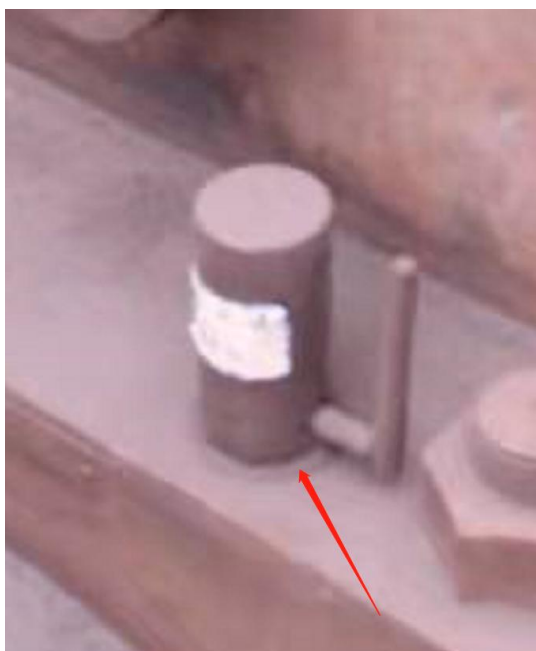
跟接触面四周一圈打上硅胶
